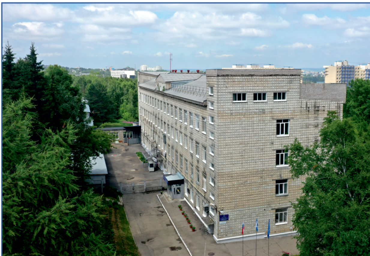
фото здания Института геохимии - 2022 г. БПЛА Сибирской школы Геонаук - ИрНИТУ
