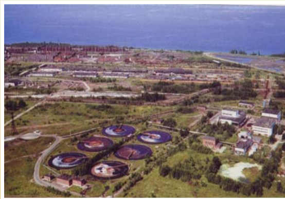
Очистные сооружения БЦБК
